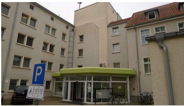
Gebäude V Aufnahme Haupteingang
