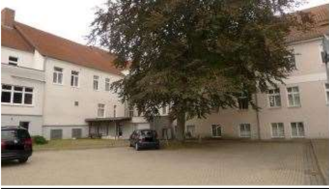
Gebäude I und II Hofansicht
