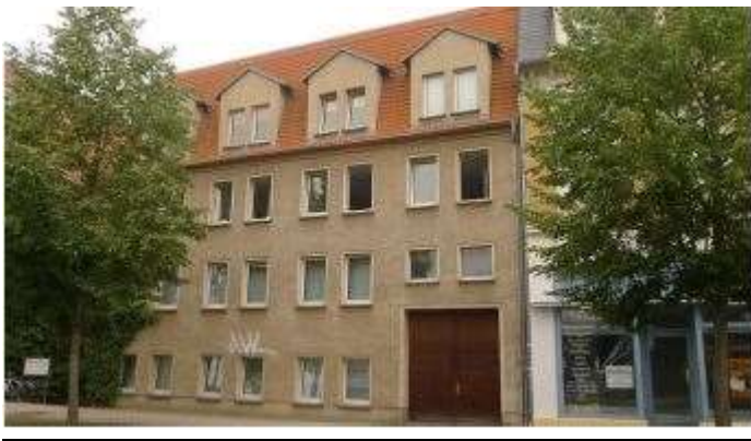
Gebäude IX Straßenfront
