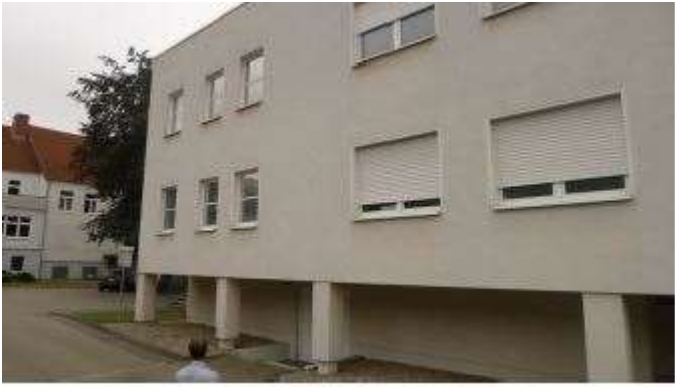
Gebäude VIII OP Trakt
