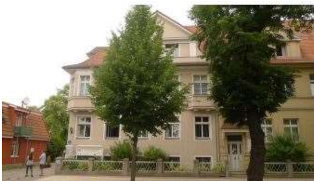
Gebäude I Straßenfront
